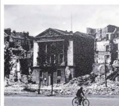
L'ex-poste principale de Nantes au milieu des ruines, allée Brancas. Photo Robert Gérard
